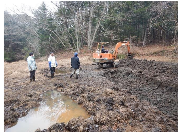
シャープゲンゴロウモドキの再導入に向けた 掘削作業 2/15
