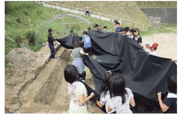
【ゴムシートの設置作業】
