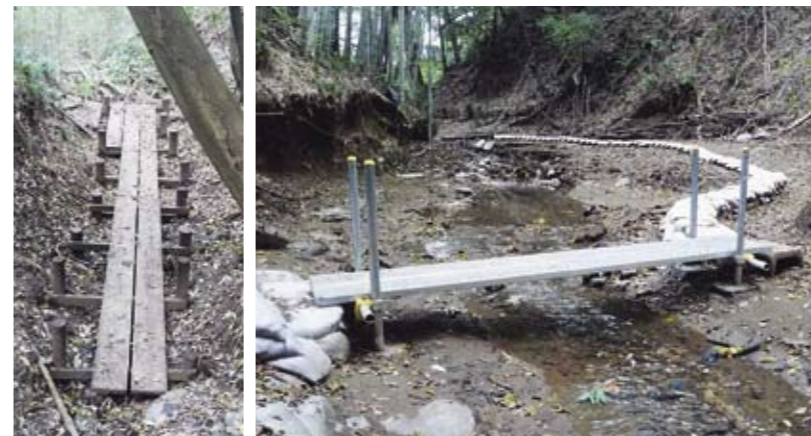
【整備した木道と橋】
