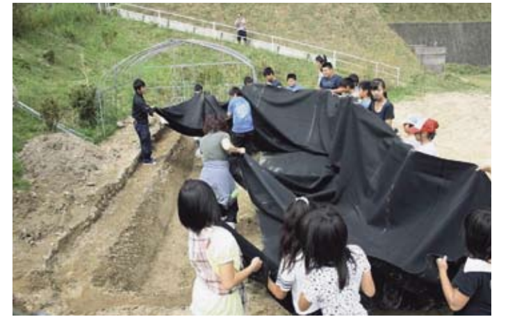
【ゴムシートの設置作業】
