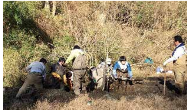
生息地となる水域を作るための掘削作業
