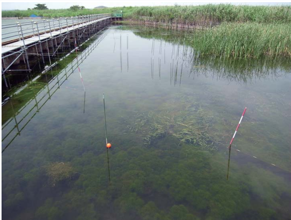
北印旛沼(成田市八代)では矢板囲い込み水位低下法にて土着の沈水植物群落を復活
