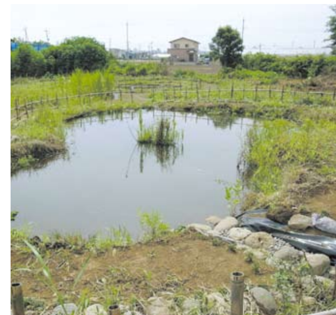
整備中の小川と池
