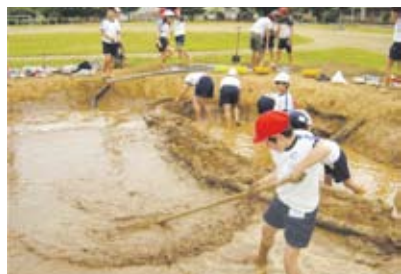
ビオトープの改修(粘土貼り)
