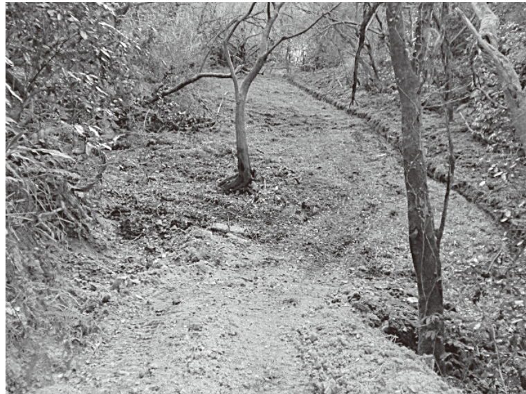
整備された作業道
