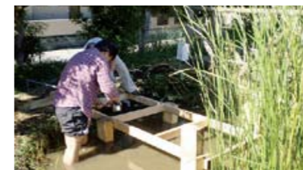
水中ポンプの移設工事
