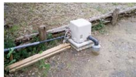
新たに掘った井戸のポンプ
