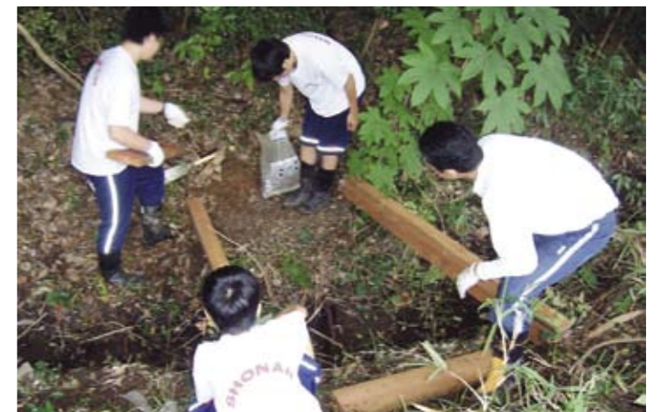
【橋の設置作業】
