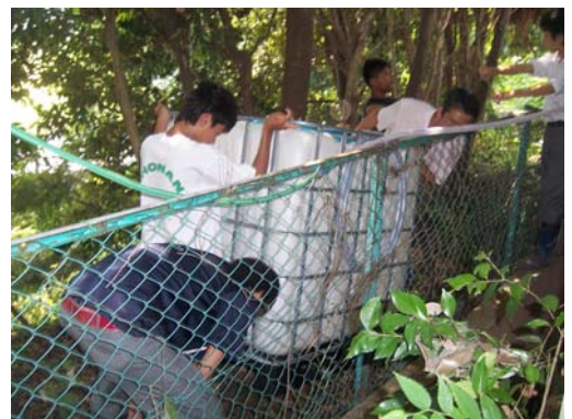
【雨水タンクの設置作業】
