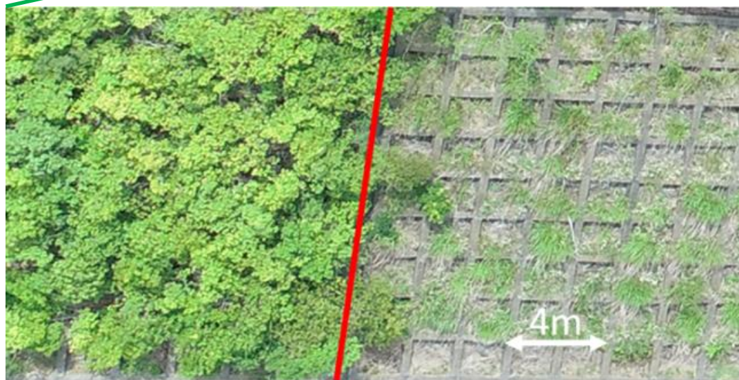
樹木により緑化した法面(左)と草本類種子を吹き付けした法面(右) 2018年7月
