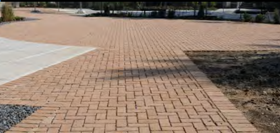
Permeable Paving市 保水性舗装市
